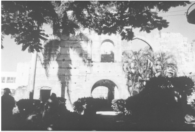
Figura 1. Ruinas del Hospital San Nicolás de Bari.
